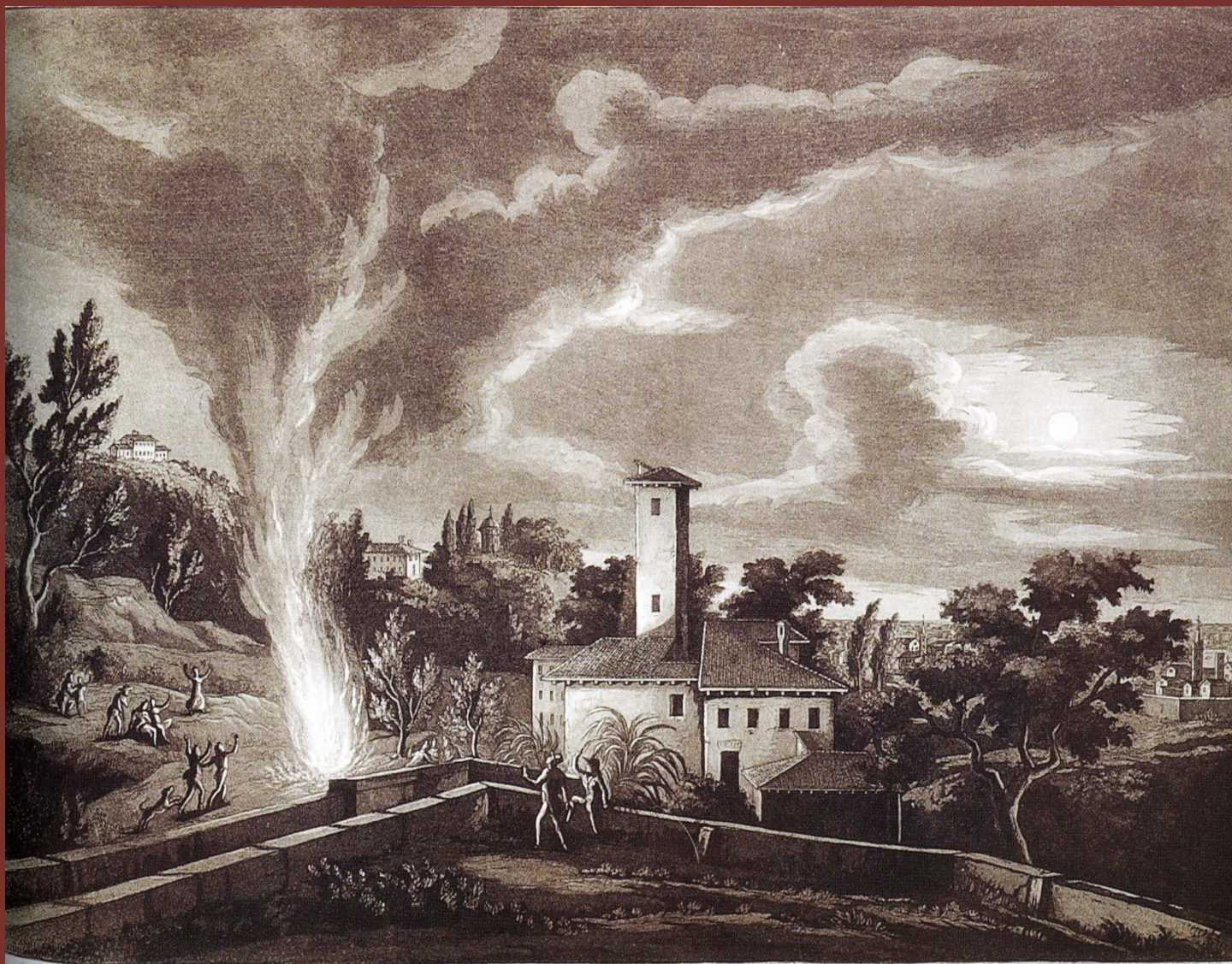
FABBRICA DELL' ACIDO SOLFORICO IN VALLE OSCURA PRESSO BOLOGNA (INSTALLATA NEL 1807 DALLA SOCIETA' ANTONIO GHERARDI E COMPAGNI?)
