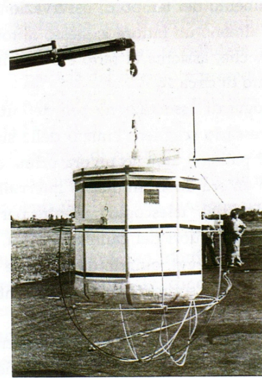
Fig. 45 - Carico ingabbiato in un sistema di smorzamento dell'urto alla caduta a terra
